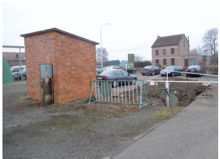
De oude electriciteitskabine op de parking werd ontmanteld en kan nu door de club gebruikt worden
