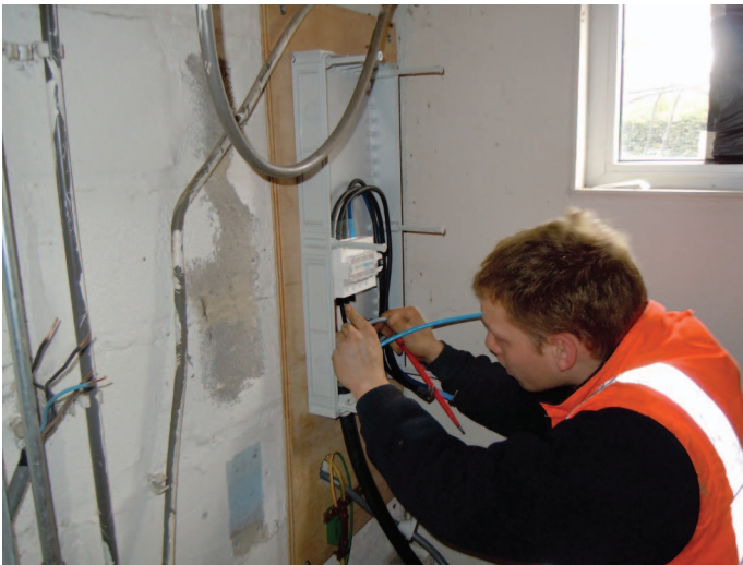
De aansluiting van de nieuwe electriciteitskabel
